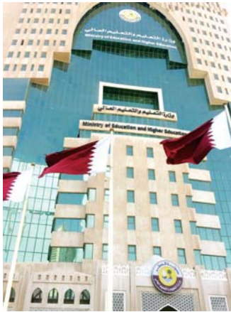
● مبنى وزارة التعليم
